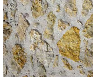
Moellons enduit garnissant
