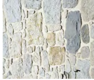
Moellons et pierres taillées à jointement
