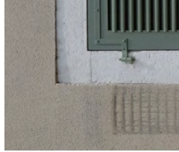
Encadrement en creux non enduit et peint
