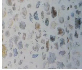
Galets et pierres tout venant recouverts d'enduit
