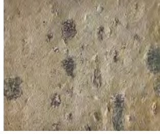
Galets et pierres tout venant recouverts d'enduit
