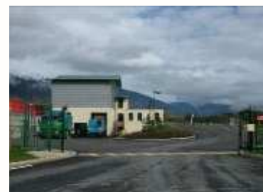
Quai de Transfert de Crozet
