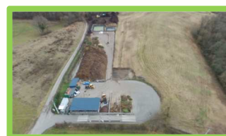
5-Plateforme compostage Baraty
