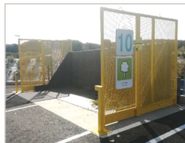
Trémie de déversement des déchets verts et quai de déchargement de la déchetterie d'Ornex
