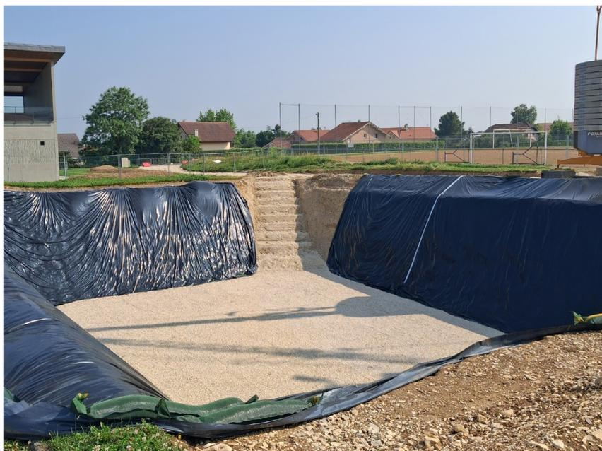
Dans une démarche proactive face aux enjeux climatiques, la commune investit dans un système de récupération et de stockage des eaux pluviales issues de bâtiments municipaux. Le projet prévoit l'installation d'une cuve de stockage enterrée d'une capacité de 600 m<sup>3</sup>, permettant de réaliser 6 à 8 arrosages des espaces verts et terrains sportifs.
